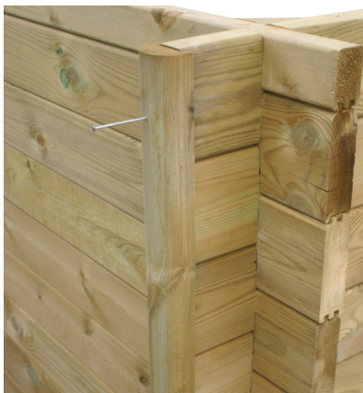
Figura 20 – Revestimientos de madera
