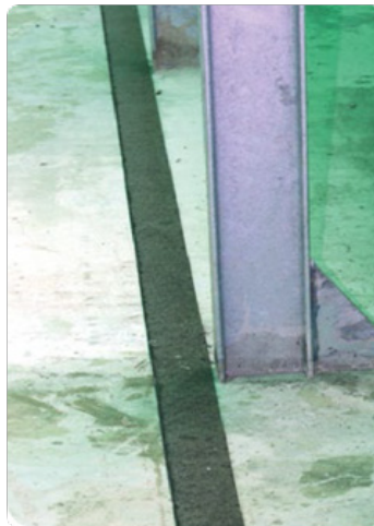
Figura 8 – Instalación de tiras bituminosas
