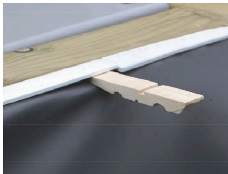
Figura 32 – Bloqueo del liner con pinzas de la ropa
