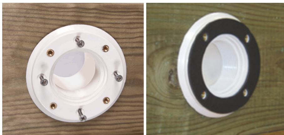
Figura 24 – Montaje del cuerpo de la boquilla de retorno y su junta
